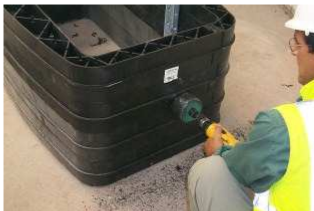
Håltagning med hjälp av hålsåg.
