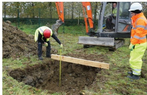
Kontroll av urgrävningsdjup
